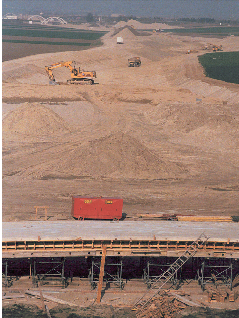
Abb. 2: Bau des Marchfeldkanals im Abschnitt Gerasdorf bei Wien (Foto: Marchfeldgesellschaft).
