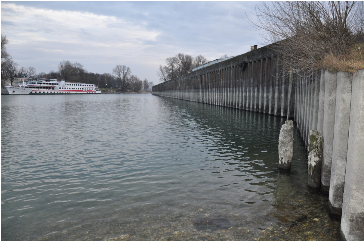
Abb. 1: Der Beginn des Werftarms in Korneuburg.
